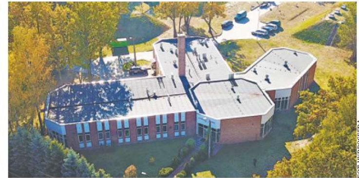
Stacja uzdatniania wody w Józefowie – widok z lotu ptaka
