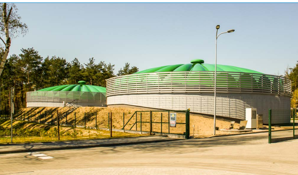
Fot. 1 | Reaktory biologiczne Oczyszczalni Ścieków w Józefowie
