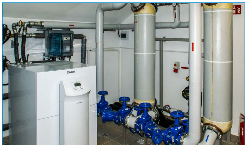
Fot. 5 | Instalacja odzysku ciepła ze ścieków oczyszczonych
