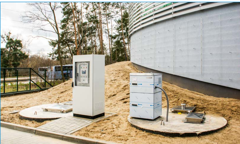
Fot. 7 | Komora pomiaru jakości ścieków oczyszczonych z lampą UV
