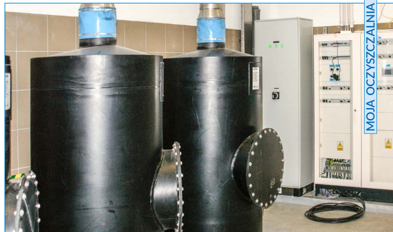
Fot. 8 | Instalacja dezodoryzacji
