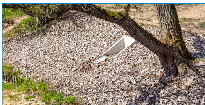
Fot. 10 | Wypływ ścieków oczyszczonych
